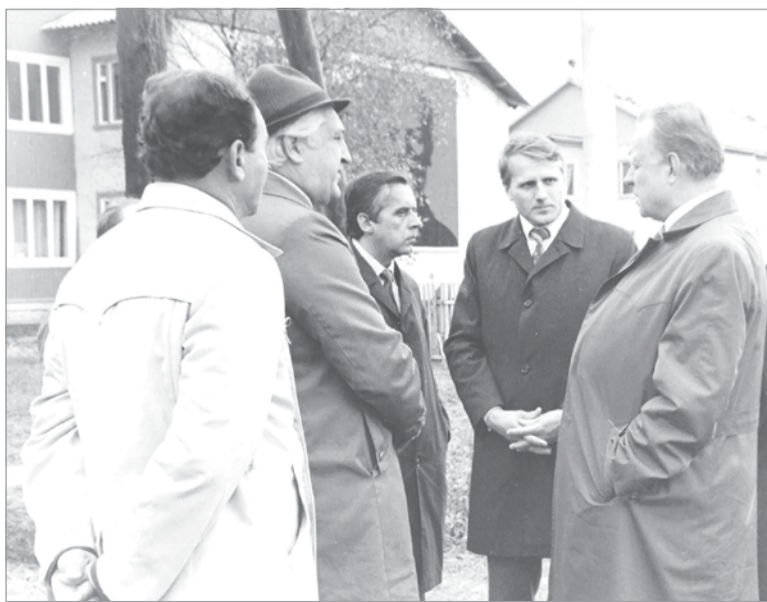
Завершение строительства новых домов из арболита в Вахновской Каре
