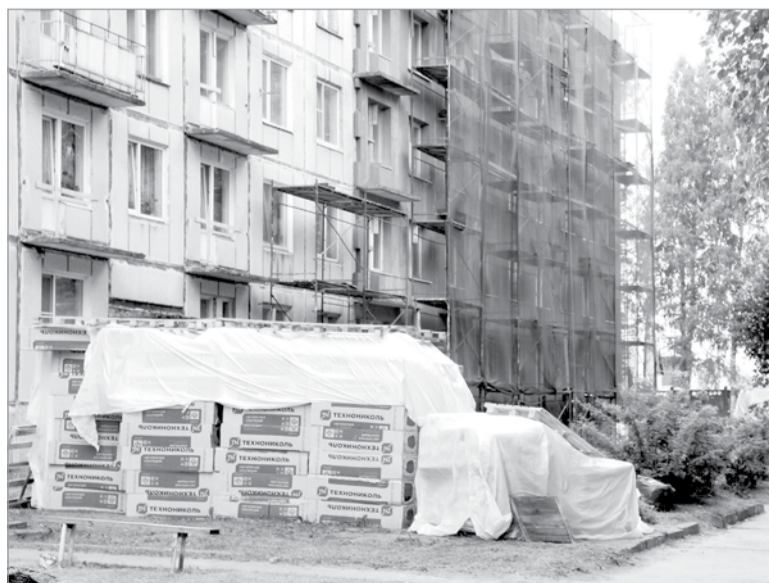
Ремонт фасадов производится с утеплением домов
