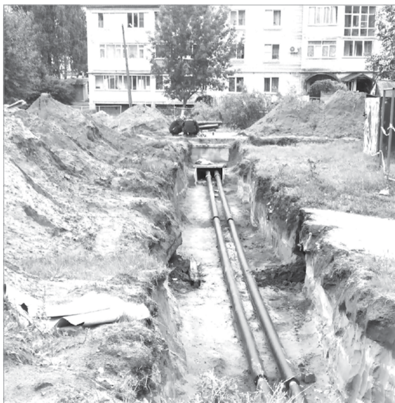
Ремонт теплотрассы за зданием гостиницы «Свирь»
